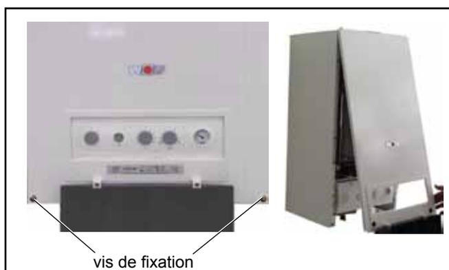
Desserrez les vis du couvercle supérieur (gauche / droite).
