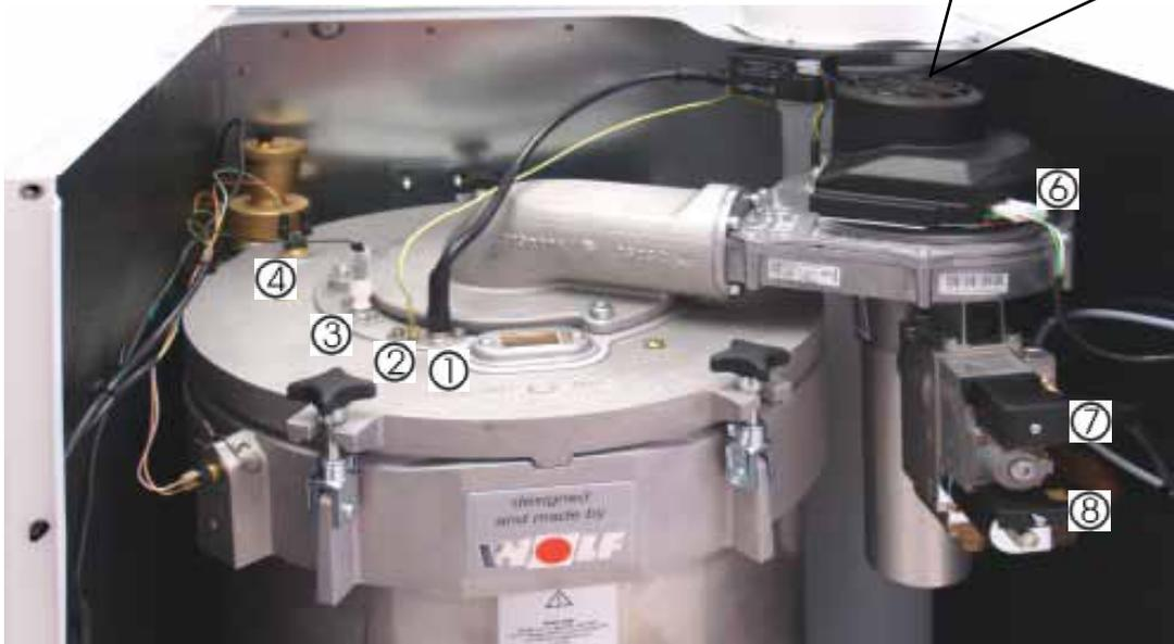
Dévissez le raccord fileté pour le gaz sur la valve combinée à gaz.
