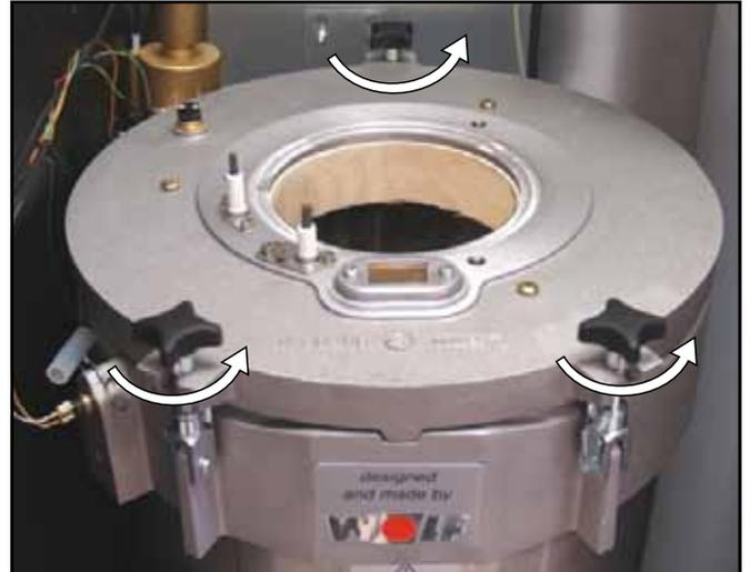
Soulevez le couvercle de l'échangeur thermique à l'aide de l'outil d'entretien.
