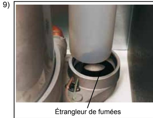
Placez l'étrangleur de fumées Ø 53 mm dans la cuve de condensation et remettez le tube des fumées en place.
