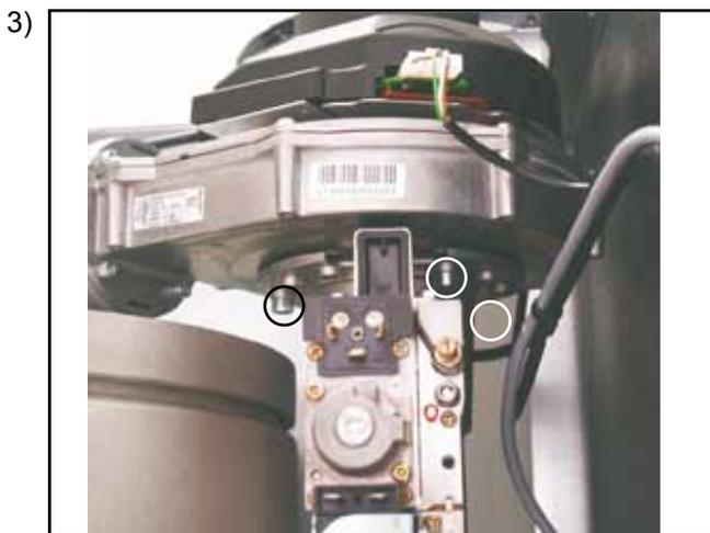
Dévissez la chambre de mélange du ventilateur (3 x vis à six pans creux 5 mm), retirez éventuellement le tube d'admission d'air
