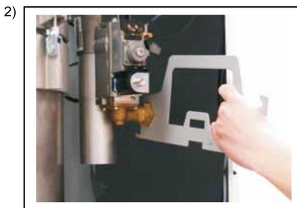
Dévissez le raccord fileté pour le gaz sur la valve combinée à gaz
