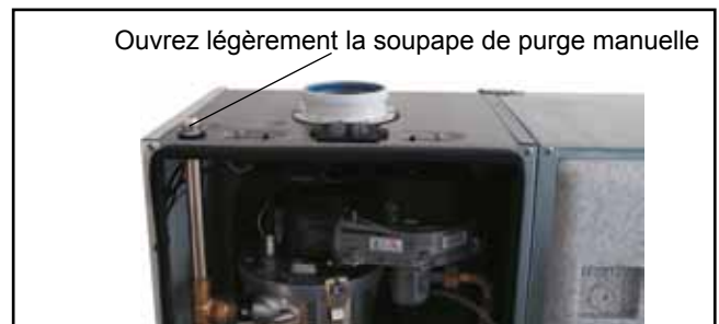
Illustration : soupape de purge manuelle
