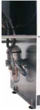
Filtre à fioul monté dans la chaudière
