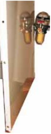
Filtre à fioul monté à l'extérieur sur la chaudière
