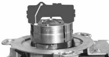
**17. 2<sup>ème</sup> contrôle : la position de l'électrode d'allumage est-elle correcte ?**
