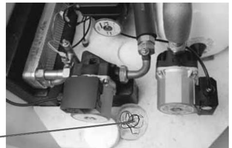
Anode de protection supérieure à l'avant du ballon
