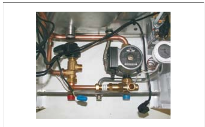
Illustration: bloc de raccordement démonté
