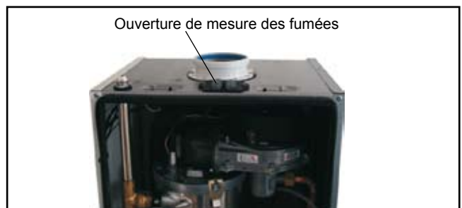
Illustration: Mesure des fumées appareil ouvert
